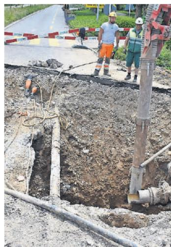
Mit einem Saugbagger holen Arbeiter Dreck und Geröll aus der Baugrube am Kreisel.
